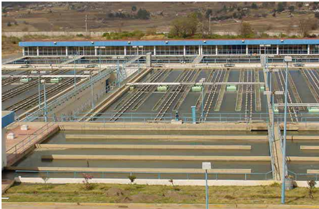
Vista Frontal de un modulo de Filtros, Planta Potabilizadora Los Berros del Sistema
