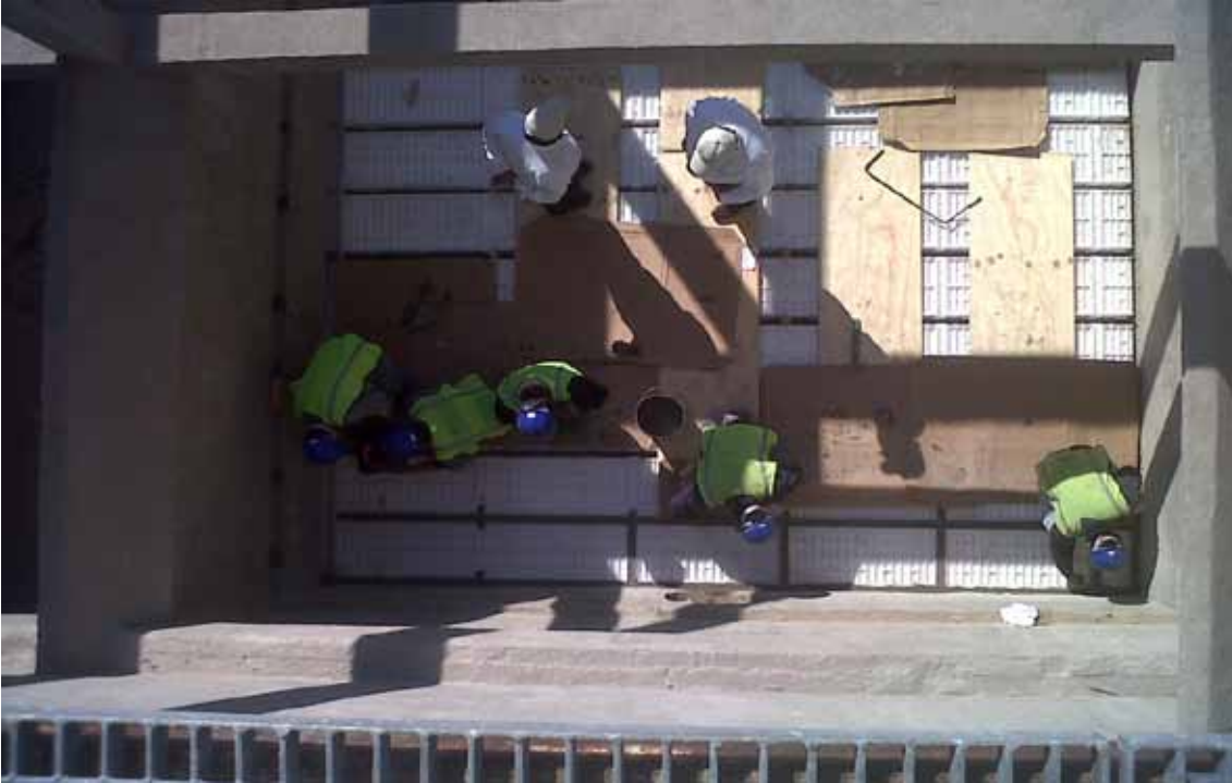
Colocación de Falsos Fondos Severn Trent
