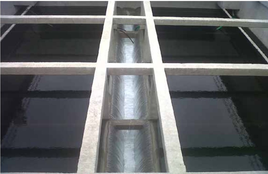
Retrolavado en filtro y prueba de desempeño
