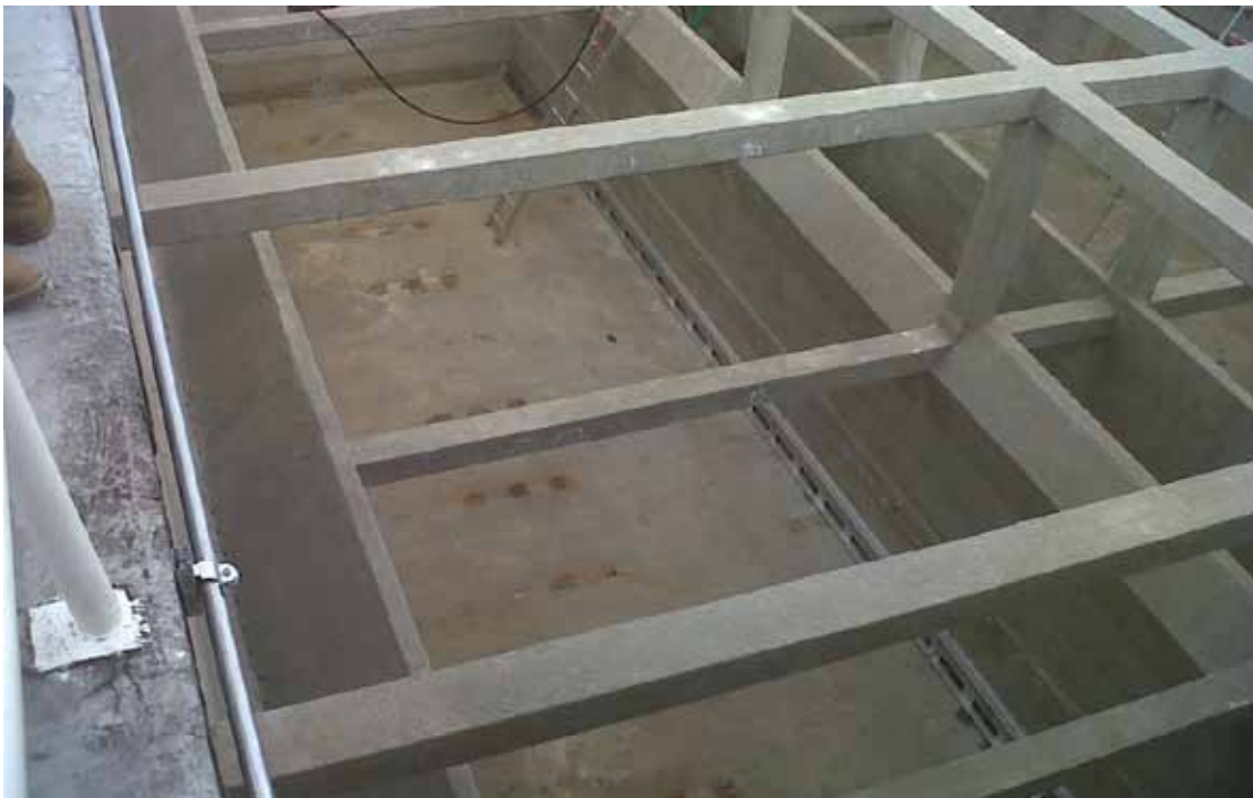
Limpieza de Fondo y Aplicación de impermeabilizante Xypex
