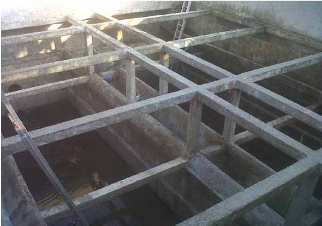
Lavado de Muros a poro abierto
