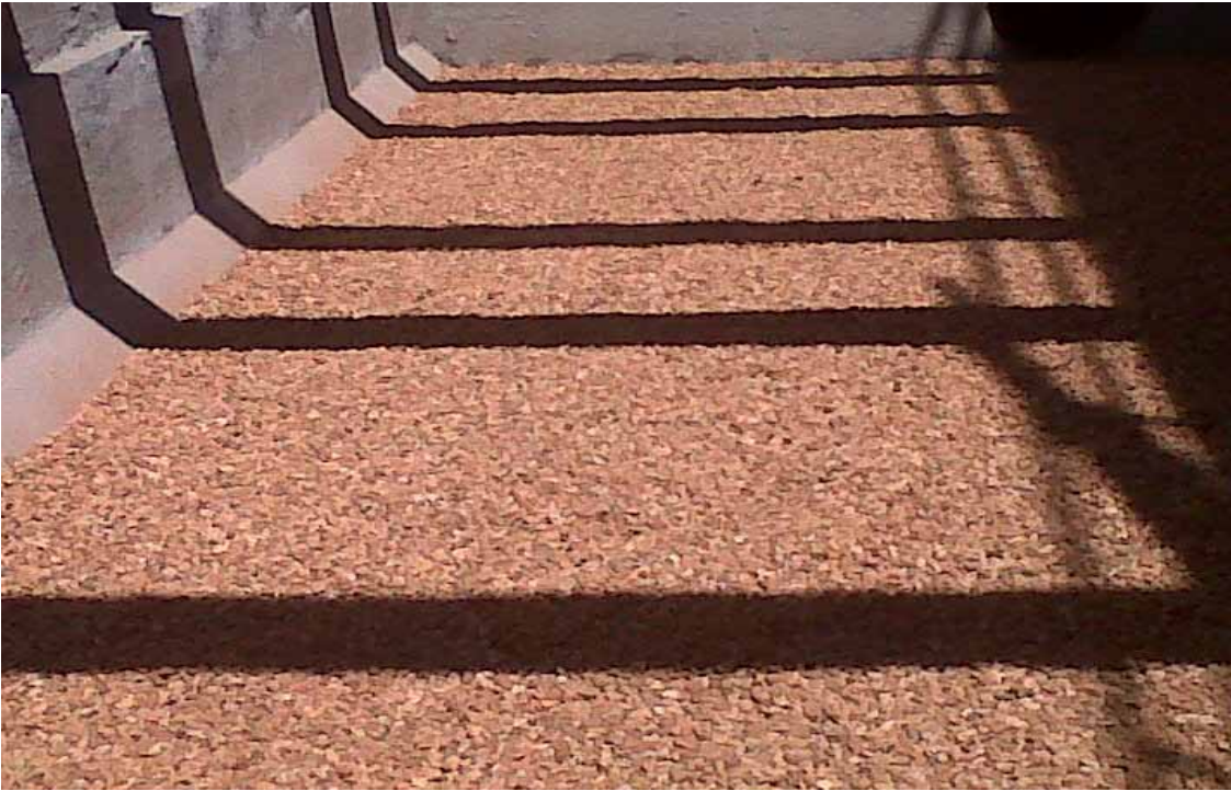
Colocación de material filtrante Grava Cuarzosa
