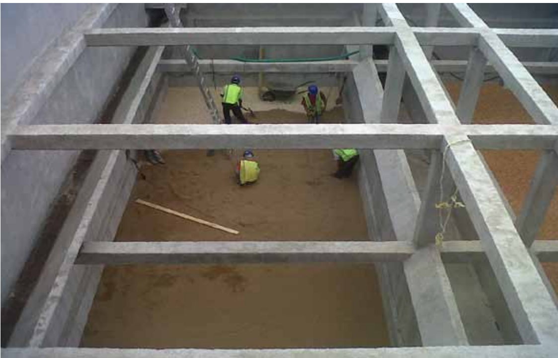
Colocación de material filtrante Arena silica
