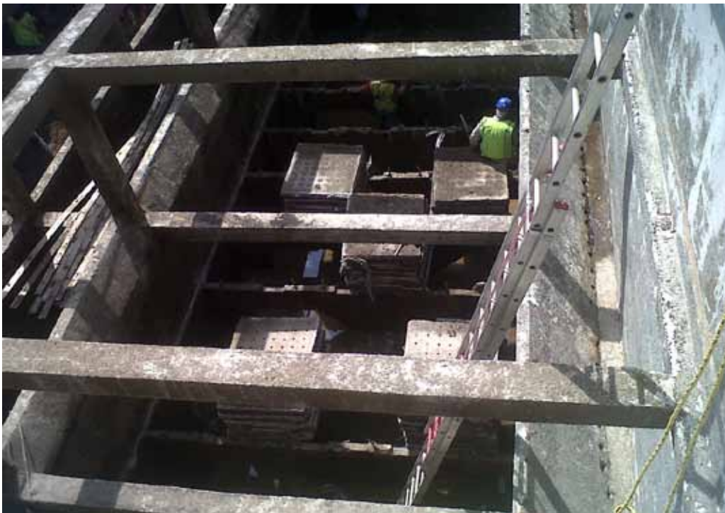
Retiro de Losas de Falso Fondo Existentes
