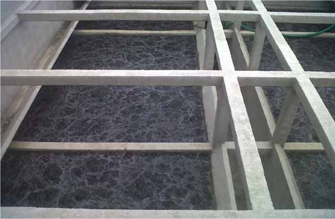
Colocación de Antracita y lavado del material filtrante
