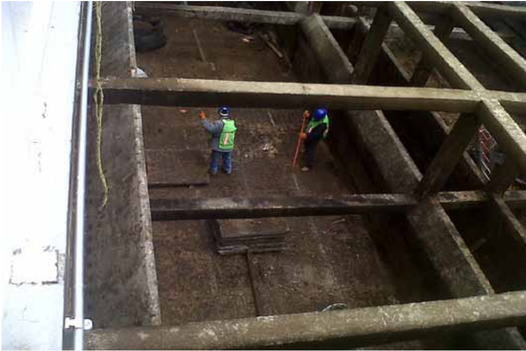
Retiro de Losas de Falso Fondo Existentes
