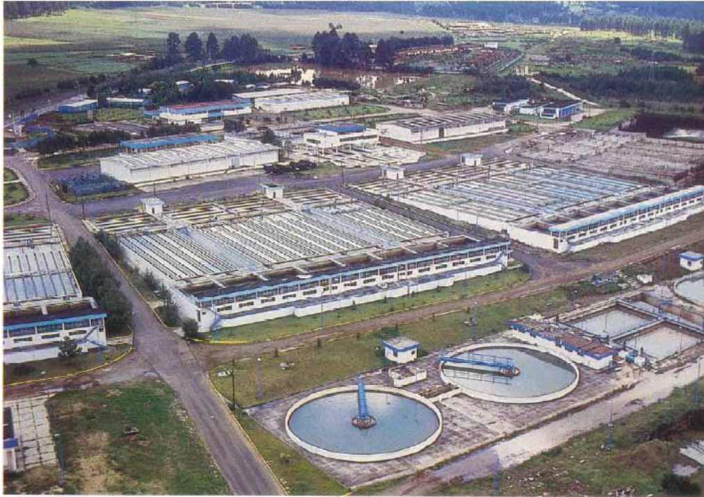
Vista Panorámica de la Planta Potabilizadora Los Berros, Villa de Allende, Edo de México
