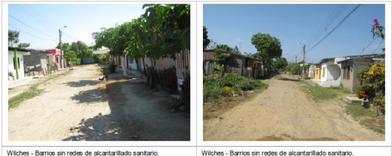
Imagen 2. Barrios sin redes de alcantarillado
